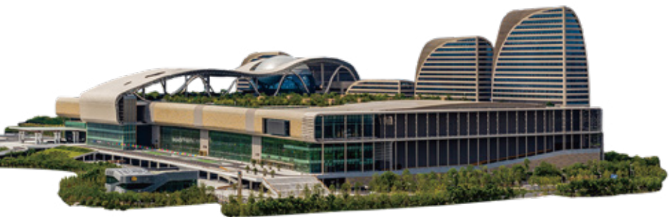
杭州国际博览中心
